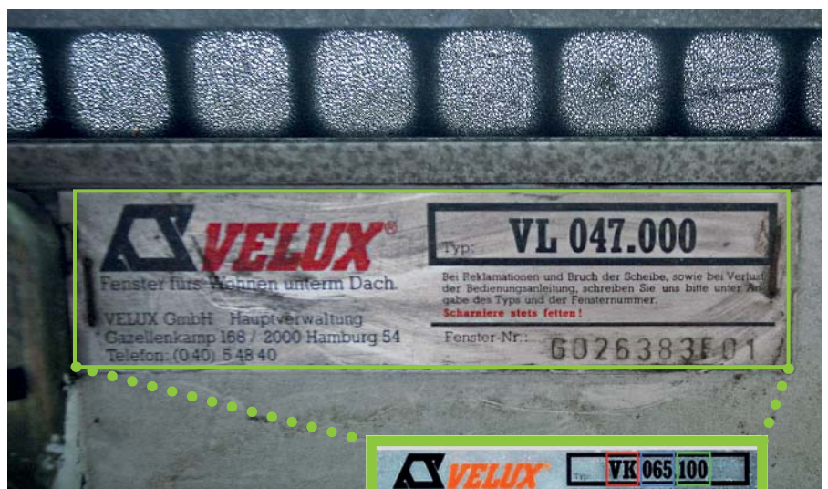
Anhand des Typenschildes am Dachflächenfenster kann das Produktionsjahr jedes Dachflächenfensters eingegrenzt werden. Die Fensternummer gibt genauen Aufschluss über das Produktionsjahr, das bei der Firma Velux erfragt werden kann. In diesem Fall war das Fenster im Jahre 1983 produziert worden.
